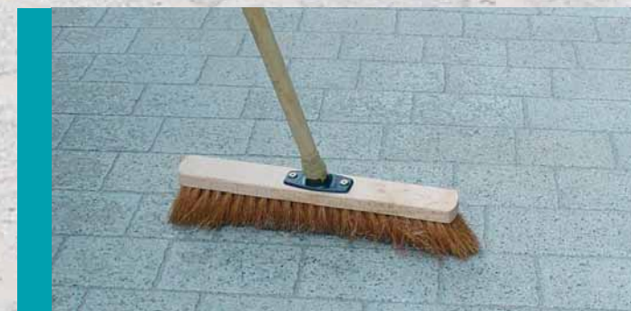
Kuva 6: Ylimääräiset saumalaastit voidaan heti saumauksen jälkeen harjata pois seuraavaan työkohteeseen.
